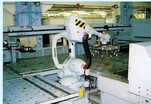
●ロボットの据付・調整
